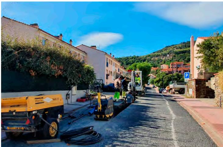
Les travaux, actuellement en cours, consistent en des terrassements, créations de bordures et caniveaux, création du réseau d’assainissement pluvial, créations de trottoirs en bétons, réfection de la voirie en enrobé, mise en esthétique des réseaux en lien avec le SYDEEL66 et réparations si nécessaire sur les réseaux d’eau potable et d’assainissement eaux usées.
